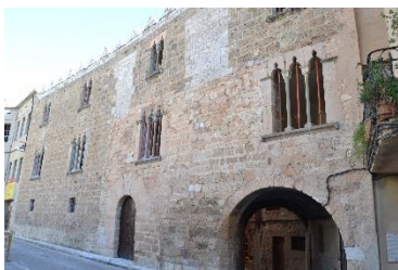
Vista de la fachada del Palacio del Marqués de Lió.
