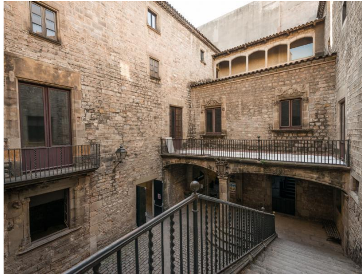
View of the Palacio de los Marquesos de Llió located on the Montcada street of the city of Barcelona 124
